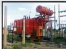
**E.R. San Pedro:** La ciudad de San Pedro se abastece de la Estación Transformadora (E.T.) San Pedro que cuenta con un solo transformador de 132/33/13,2 kV de 30 MVA de potencia. Dada la importancia de la demanda abastecida, se habilitó una E.R. con un transformador 33/13,2 kV de 20 MVA de potencia. Esto asegura el abastecimiento ante situación de falla del transformador de la E.T.
