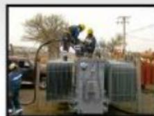
**E.R. Calilegua:** Se reemplazó el transformador por uno de 33/13,2 kV de 5 MVA de potencia, representando un aumento de un 100% de la capacidad instalada.
