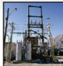
**E.R. Volcán:** Se instaló un banco de reguladores de tensión de 33 kV con una potencia de 11,4 MVA.
