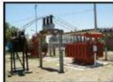
**E.R. Perico:** Se agregó un transformador de 33/13,2 kV de 2,5 MVA de potencia, representando un aumento de un 14% de la capacidad instalada.
