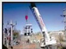
**E.R. La Quiaca:** Originalmente contaba con dos transformadores de 33/13,2 kV de 5 MVA y de 2,5 MVA de potencia. Dada la importancia de la demanda abastecida, se reemplazó el transformador de 2,5 MVA por uno de 5MVA de potencia, representando un
