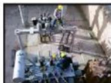
**E.R. Abra Pampa:** Se reemplazó el transformador por uno de 33/13,2 kV de 2,5 MVA de potencia, representando un aumento de un 66% de la capacidad instalada.
