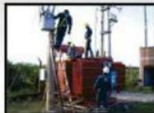
**E.R. El Carmen:** Se reemplazó el transformador por uno de 33/13,2 kV de 7,5 MVA de potencia, representando un aumento de un 50% de la capacidad instalada.
