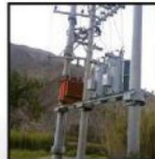
**E.R. Purmamarca:** Se instaló un banco de reguladores de tensión de 13,2 kV con una potencia de 2,3 MVA.
