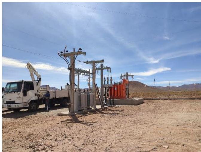
En el nuevo edificio del Complejo Penitenciario de Chalicán, enmarcado en el Plan Maestro y financiado por el gobierno provincial, se realiza la energización del conjunto celdas de 33kV y el transformador de 1600 kVA de 33/0,4 kV y mediciones de tensión y corriente con una carga de 600 A.
